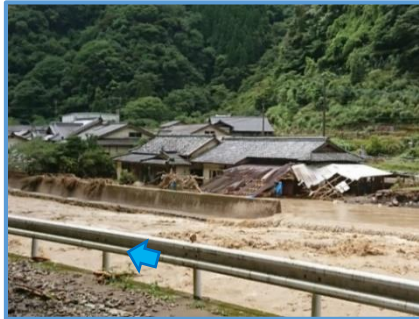
令和2年7月豪雨時の 万江川土砂・洪水氾濫状況
