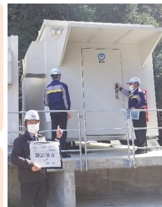
川岳交換所整備(八代市坂本町)
