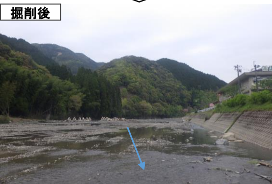
掘削前後写真(5k600付近)
