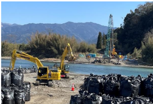
「球磨川第4橋梁」建設工事状況
