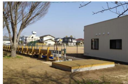
整備中の実験水路
