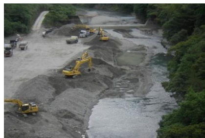
単県ダム堆砂排除事業
