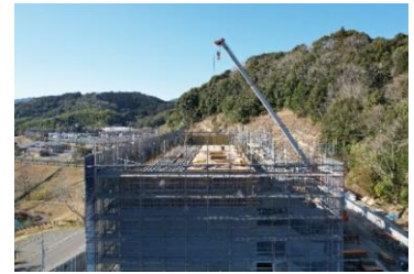
建設中の災害公営住宅(渡地区)
