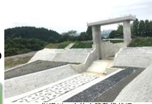
御溝川二次放水路整備状況
