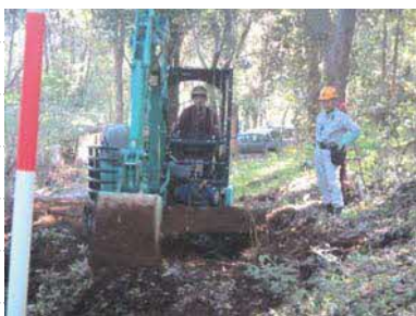
【作業道作設状況】
