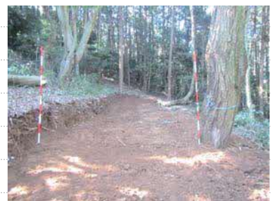
【森林作業道完成状況】
