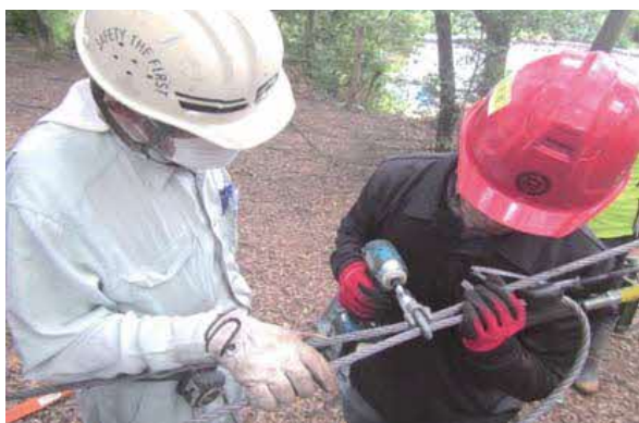
ワイヤロープ設置状況
