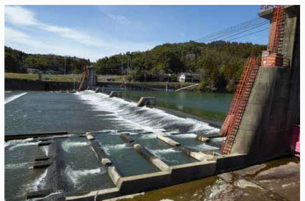
右岸側の取水口から取水した水は、取水トンネルを通過して沈砂池に向かいます。
