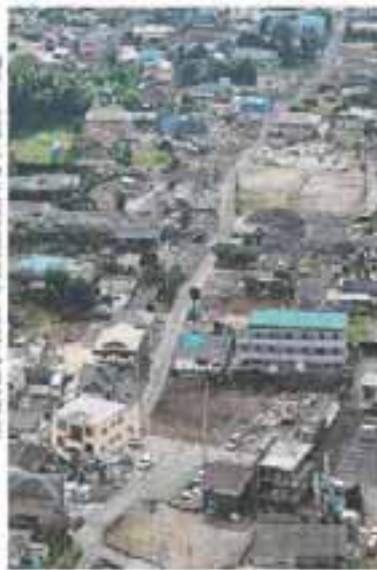
熊本地震で壊滅した住宅を市町村が実施する公費解体の10月末時点の進捗状況を公表した。計画を先行的に行っている市町村の取組は活発で、10月末時点から、急上昇した。
