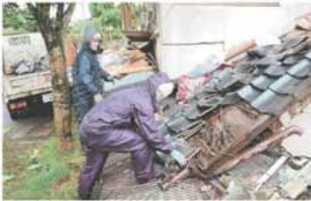
全壊した住宅の公費解体で、互を互作業で外す作業員＝14日、益城町
