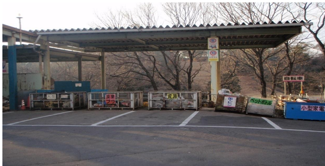
(1) 小川地区衛生組合に持ち込みされた廃蛍光管や廃乾電池を最初に荷卸しする場所（不燃物処理場）
