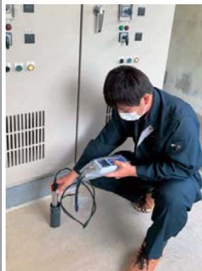
▲水源の水に濁りが無いか、濁り計で計測する様子。
