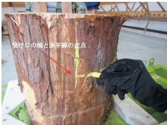
写真-8 受け口の水平方向のマーキング
