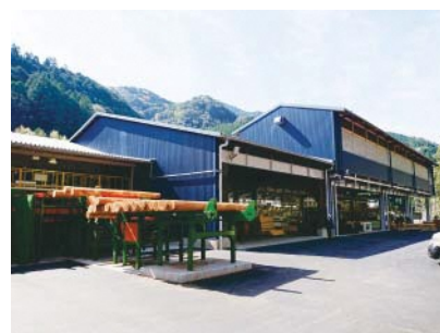
復旧が完了した球磨村森林組合 第2製材所
