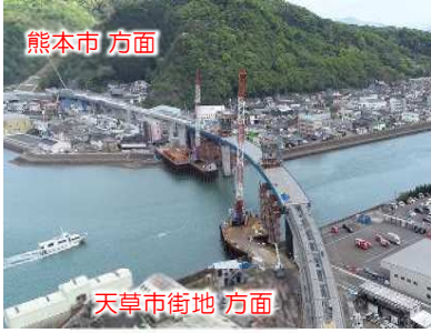
熊本天草幹線道路(本渡道路)
