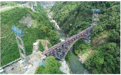
南阿蘇鉄道災害復旧工事(第一白川橋りょう)
