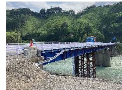
仮橋の設置状況(相良橋)
