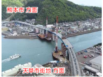
熊本天草幹線道路(本渡道路)
