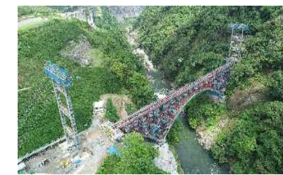
南阿蘇鉄道災害復旧工事(第一白川橋りょう)
