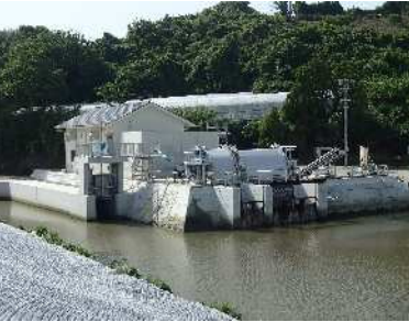
農業生産基盤整備(大口西部排水機場)
