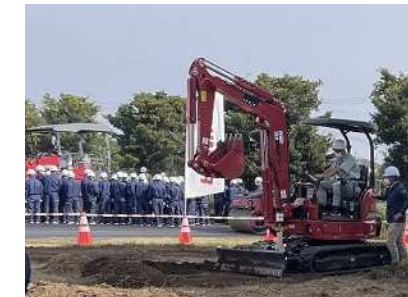
高校生向け「建設業ナイストライ」(舗装実習)
