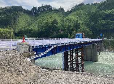
仮橋の設置状況(相良橋)
