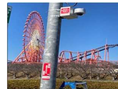
モデル地区における 見守りカメラの設置状況
