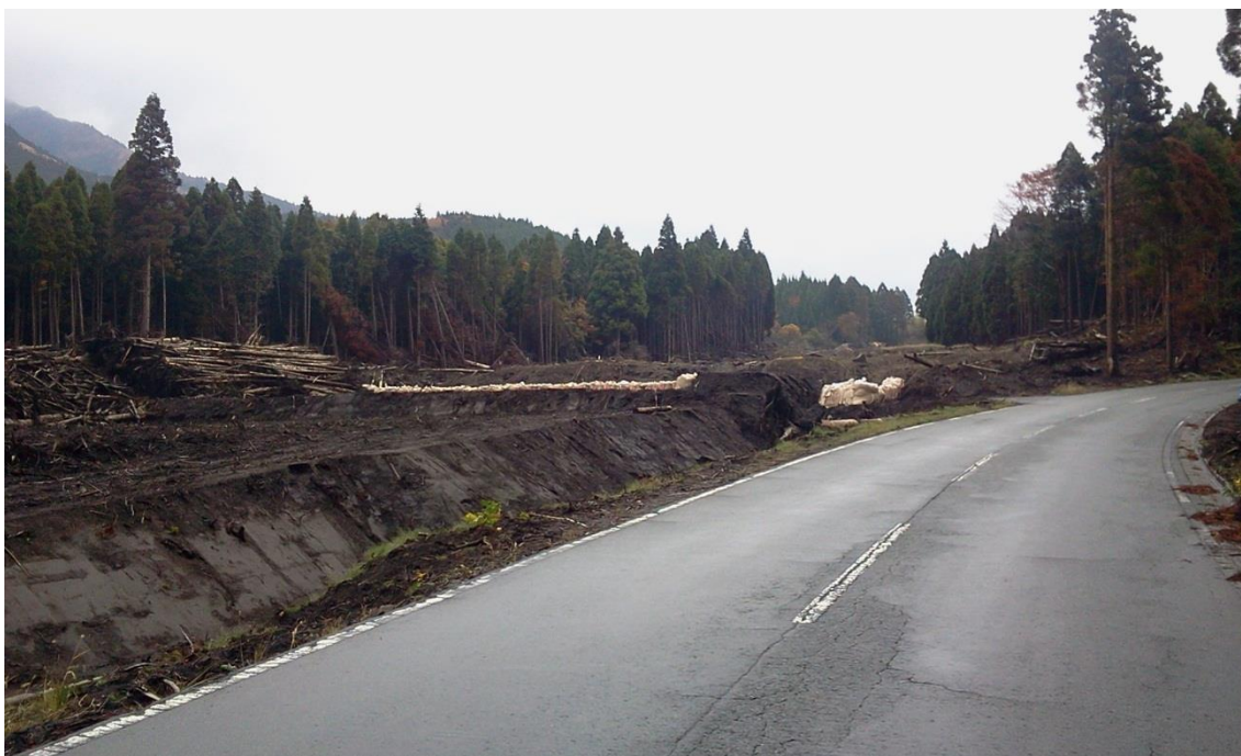
写真奥（根子岳）から手前にかけて土石流が流れ込んだ様子。 既に道路（町道）は復旧し、倒木は除去されている。
