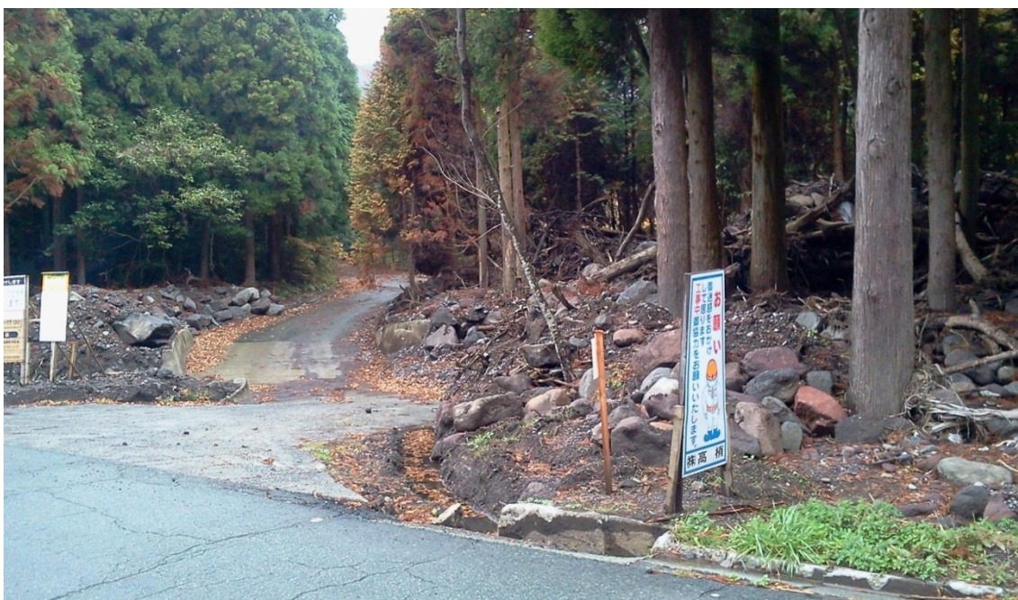
写真手前から奥にかけて土砂が流れ込んだ写真。
