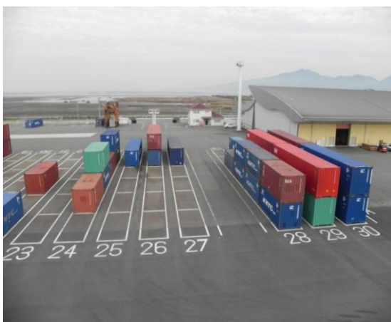
コンテナヤードと管理棟、貨物上屋
