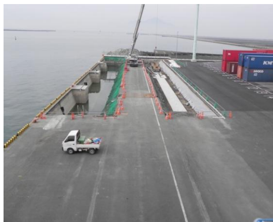
建設中のガントリークレーン基礎部
