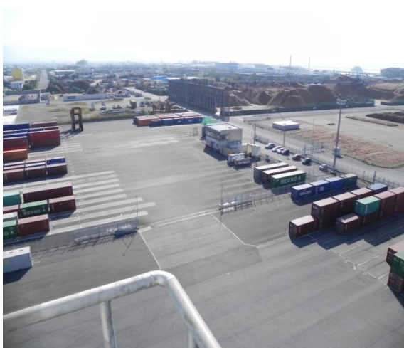
コンテナヤードと管理棟
