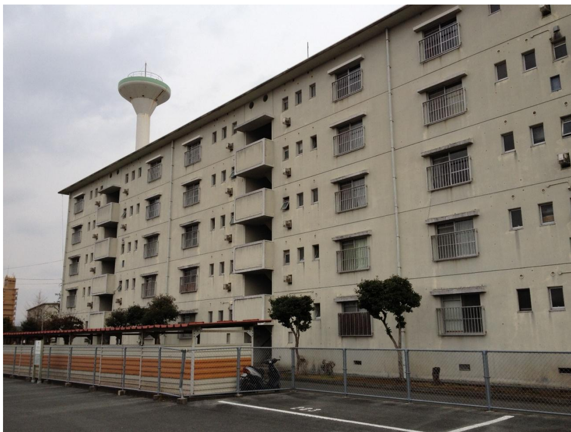
（県営住宅 42 団地のうち八反田団地の写真）
