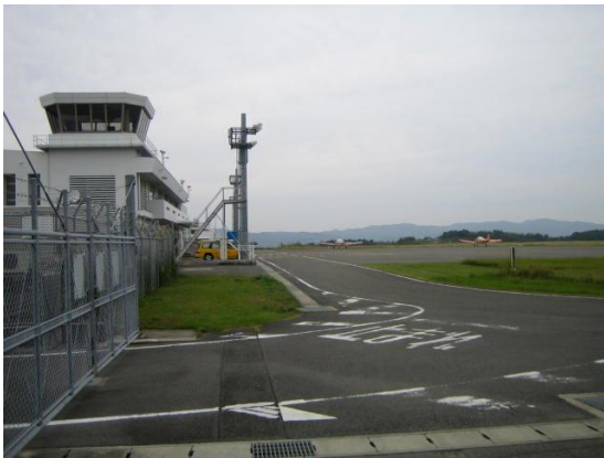
天草空港内部品格納庫付近から 管制塔方向を望む風景 (写真はすべて平成 20 年 11 月末撮影)
