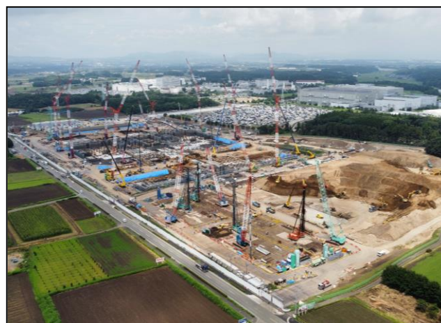
【T SMC工場新設状況】
