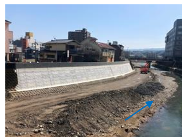
復旧状況（令和4年3月時点）
