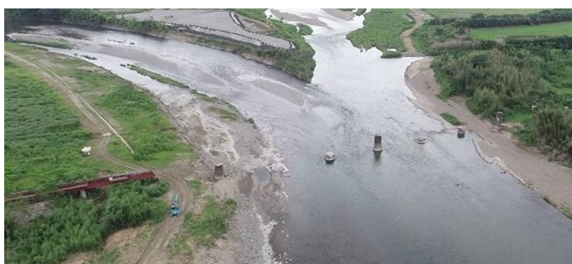
写真：「球磨川第4橋梁」付近（空撮）（流失した橋桁・橋脚等は撤去済み）
