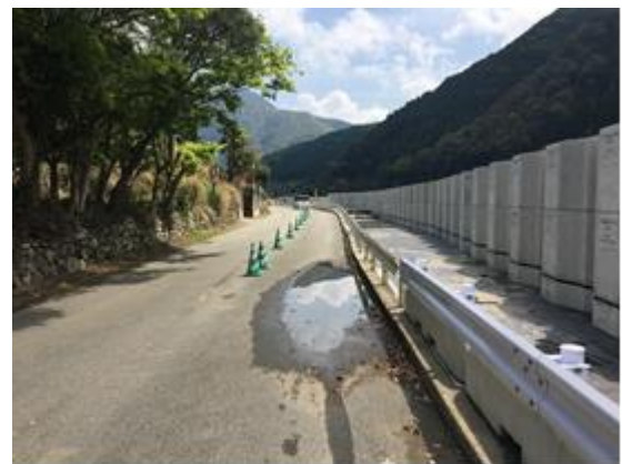
国道 219 号復旧状況
