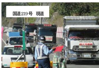
片側交互通行箇所の信号待ち状況
