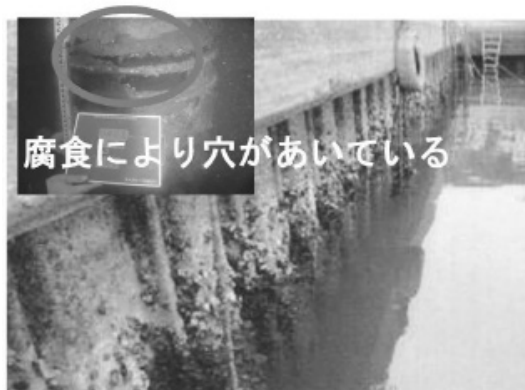
機能保全工事の実施 【着工前】
