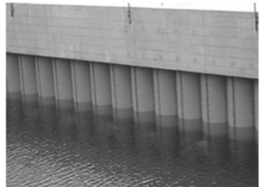
機能保全工事の実施 【竣工】
