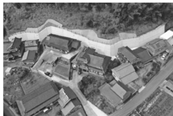
急傾斜地崩壊対策事業
