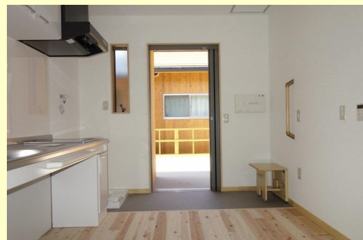
益城町福富仮設住宅：バリアフリー仮設住宅 (段差解消、引戸、手すり等を整備)
