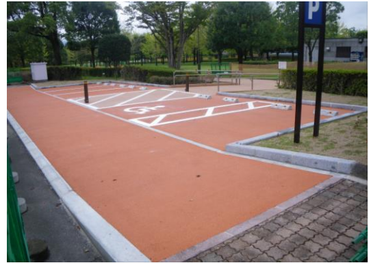
ユニバーサルデザインに基づく駐車場整備 (熊本県テクノ中央緑地)
