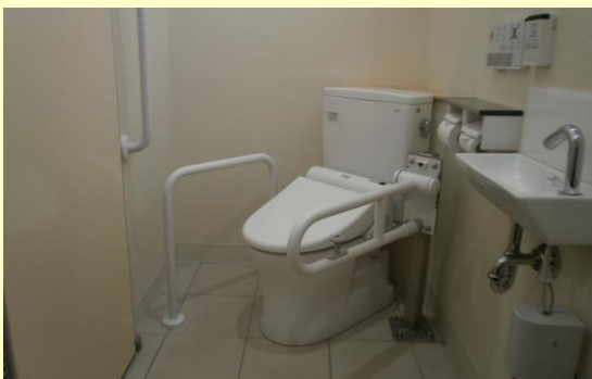
菊池市泗水公民館 (スペースや便座の向き等に配慮したトイレ)
