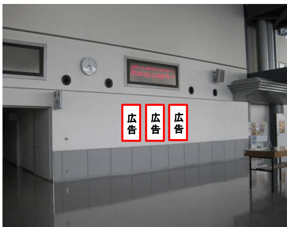
2階ロビー 運転免許試験課電光掲示板下壁面
