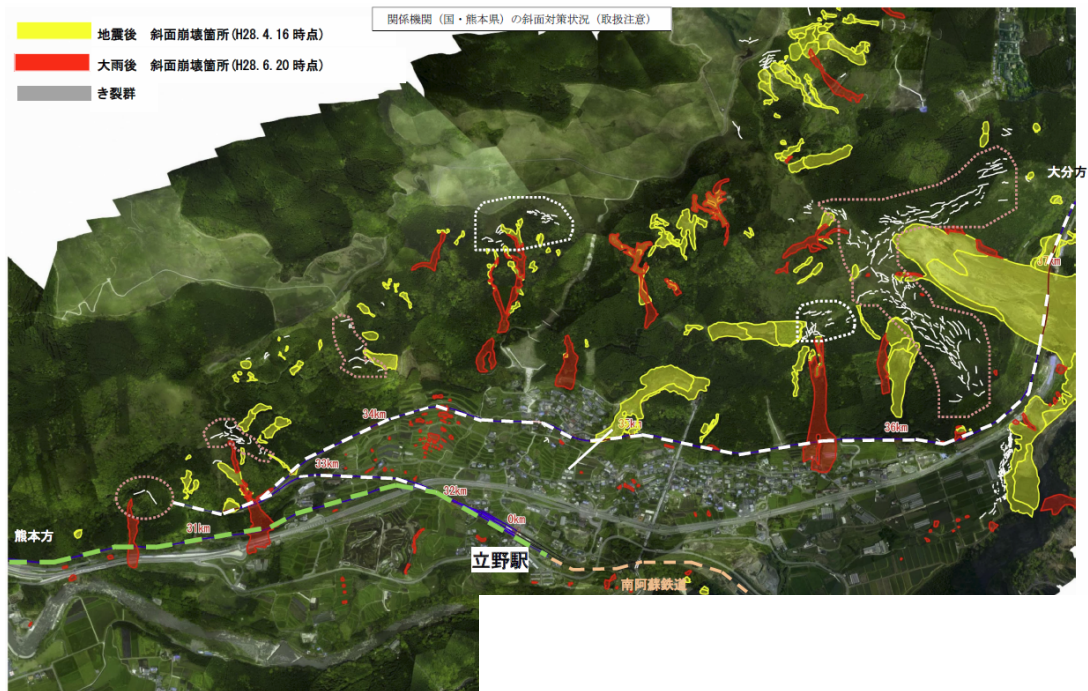
図 1.3 地震時および地震後の崩壊発生状況（JR九州提供資料に一部加筆）
