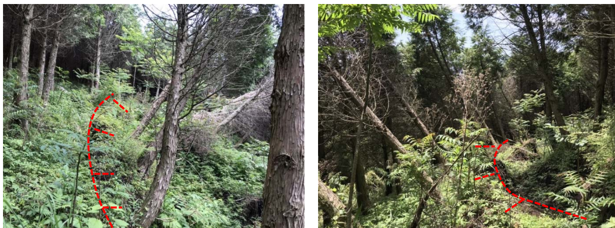
写真 7.1 樹木による亀裂の拡大
