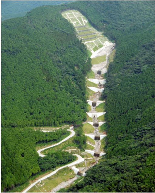
谷止工(階段状に設置)
