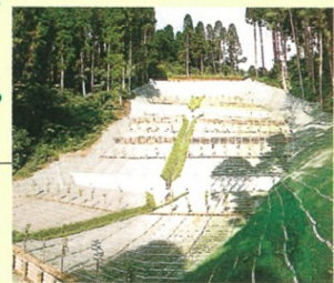
土留工 山の斜面にある不安定な土砂の移動の抑止や斜面勾配の緩和などを図り、 森林に戻すための基礎を築きます。
