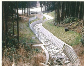
流路工 森林内を流れる渓流の流れを規制し、 渓岸や渓床の浸食を防ぎます。
