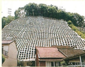
法枠工 枠材を利用して山の斜面を全面的に覆って安定させるとともに、 植物の種などを吹き付けて森林に戻します。
