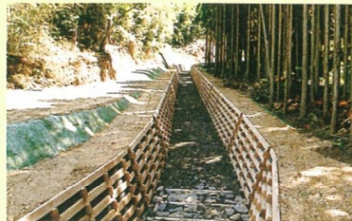
護岸工 渓流の流水による渓岸の浸食や山の崩壊を防ぎます。
