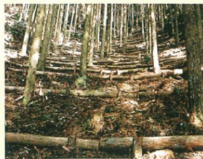
法枠工 枠材を利用して山の斜面を全面的に覆って安定させるとともに、 植物の種などを吹き付けて森林に戻します。
