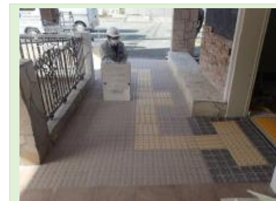
●誘導ブロックの敷設
