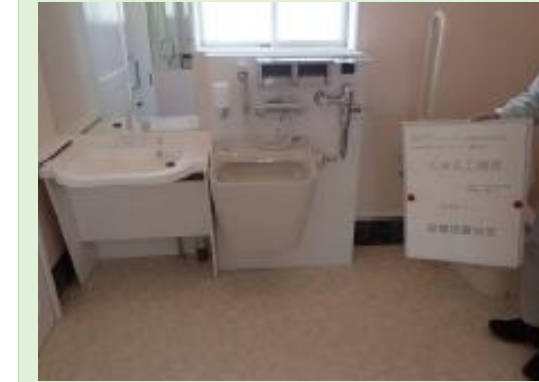
●多目的トイレの整備(新設)
