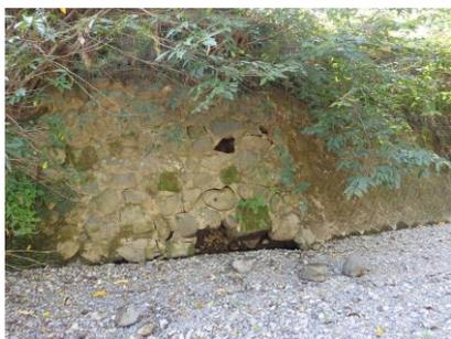
写真 2.6 巡視で確認された護岸欠損箇所
