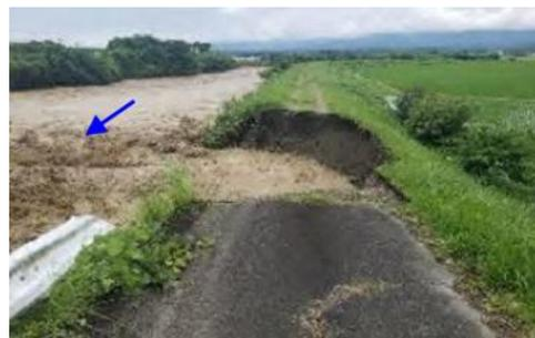
令和 2 年 7 月豪雨による免田川の堤防欠損状況（あさぎり町）
