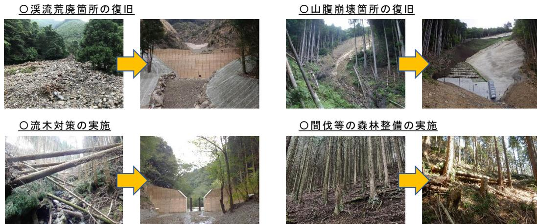
写真 5.3 治山事業による土砂・流木対策の例
