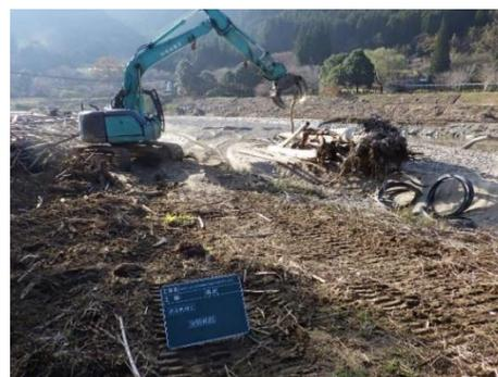
写真 5.14 ダム湛水区間における堆砂土砂の掘削や流木・ゴミの除去（市房ダム）
