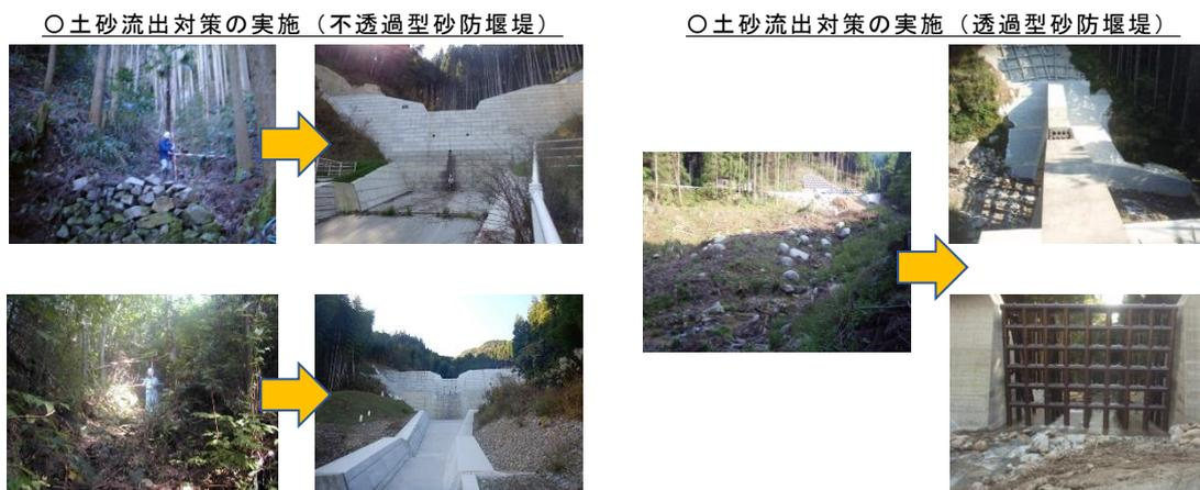
写真 5.4 砂防事業による土砂・流木対策の例
