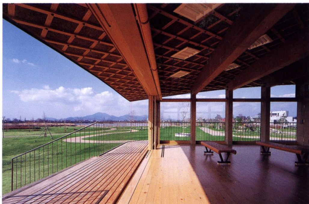
南側デッキ及び会議室
