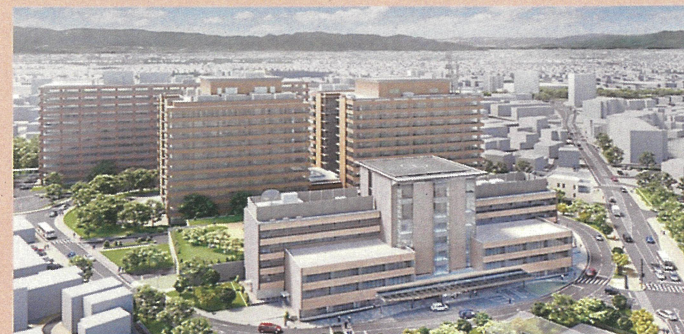
【新防災センター完成図】
