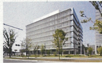
【熊本地方合同庁舎B棟】
