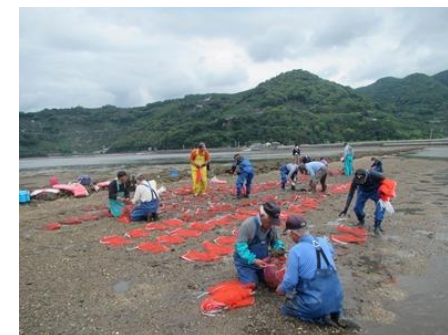
網袋設置(R3覆砂箇所 熊本市)
