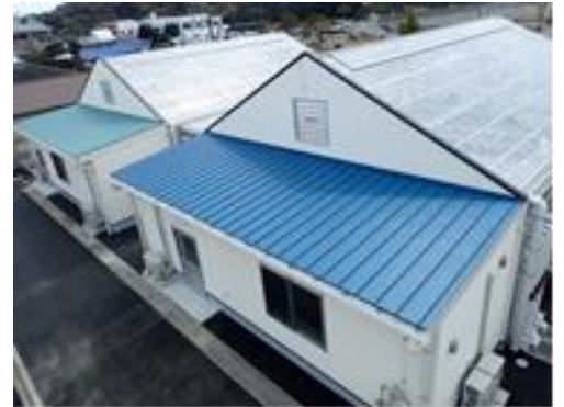
図 1 竣工した海藻研究施設
