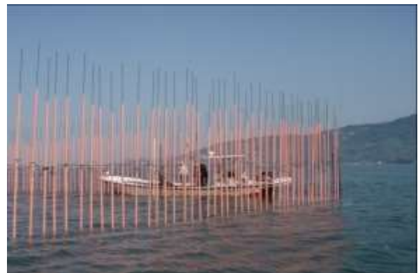
図4 FRP支柱の防護柵（有明海）
