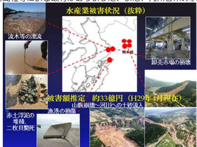
図 1 熊本地震による水産施設等被害
