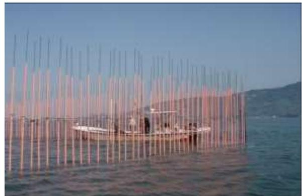
図4 FRP支柱の防護柵（有明海）
