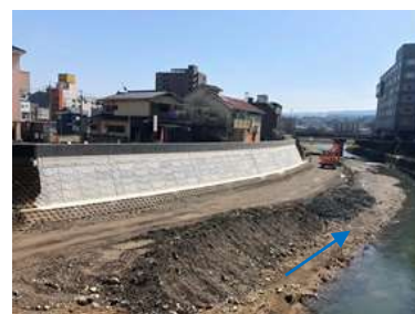
復旧状況（令和4年3月時点）
