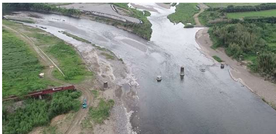
写真:「球磨川第4橋梁」付近(空撮)(流失した橋桁・橋脚等は撤去済み)
