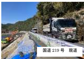
片側交互通行箇所の信号待ち状況
