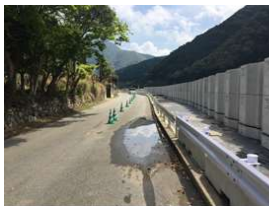
国道 219 号復旧状況
