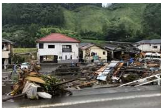
■被害状況(球磨村渡地区)
