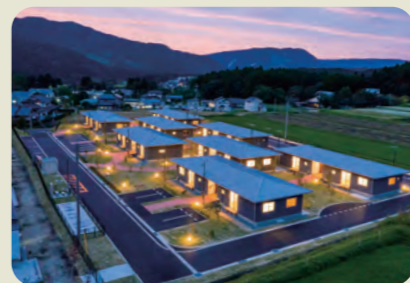
南阿蘇村買取型災害公営住宅 長陽西部・下西原第2団地
