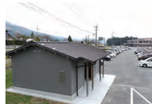
防災備蓄倉庫 [南阿蘇村]
