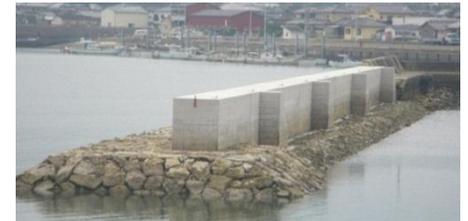
長寿命化対策「防波堤補修工」(佐伊津漁港)
