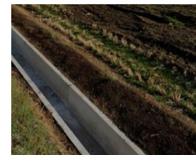
改修した水路
