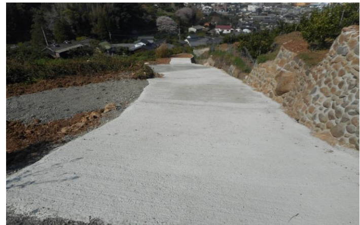
写真上は、石垣が崩れた改修前の耕作道路。写真下は整備された耕作道路。
