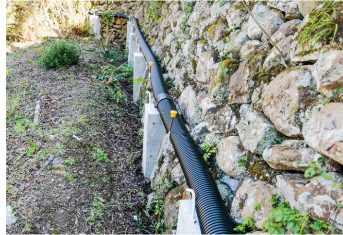
維持管理を考慮した新水路
