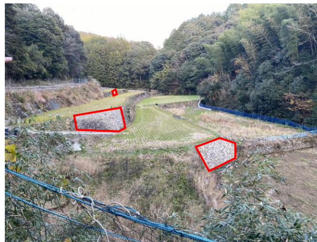
修繕した石垣3か所
