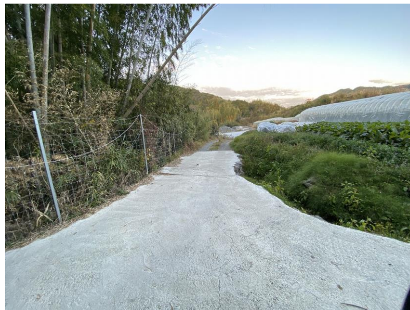
いずれも、整備した作業道
