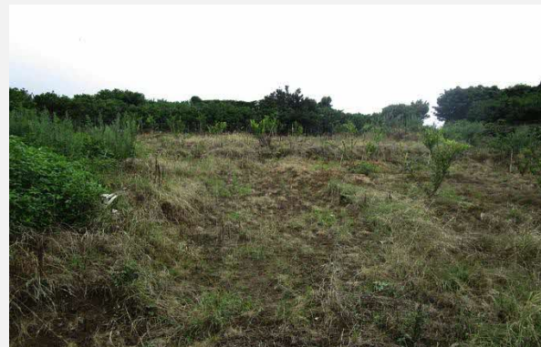
耕作道路整備前の状況
