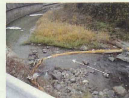
水質事故対応(オイルフェンス設置)
