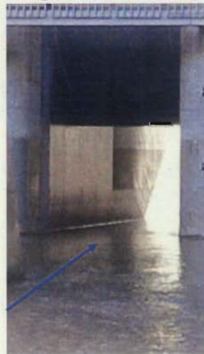
【常用洪水吐の状況】
