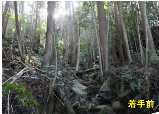
【治山事業】(谷止工)
