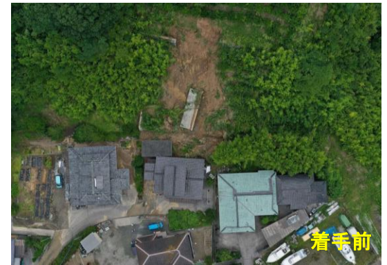
【治山事業】(山腹工)
