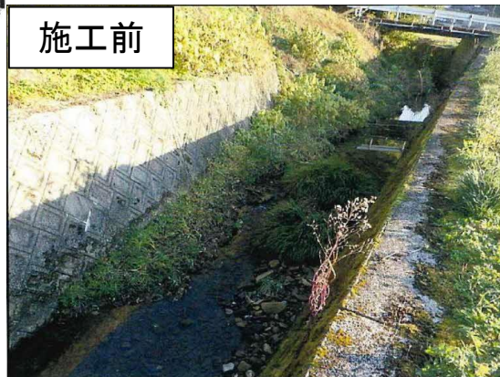
〔対策事例〕河道に堆積した土砂を緊急的に掘削
