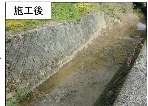
〔対策事例〕河道に堆積した土砂を緊急的に掘削
