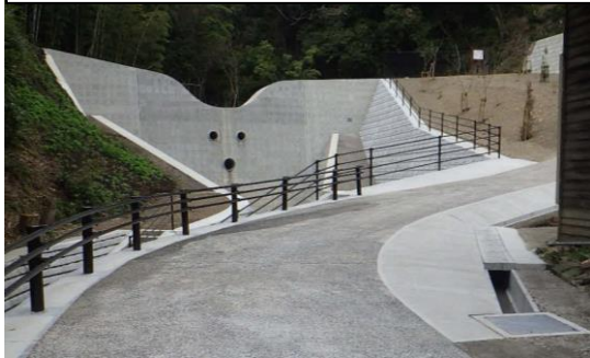
施工例 町の川内川砂防えん堤
