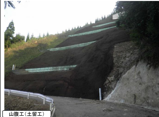
山腹工（土留工）
