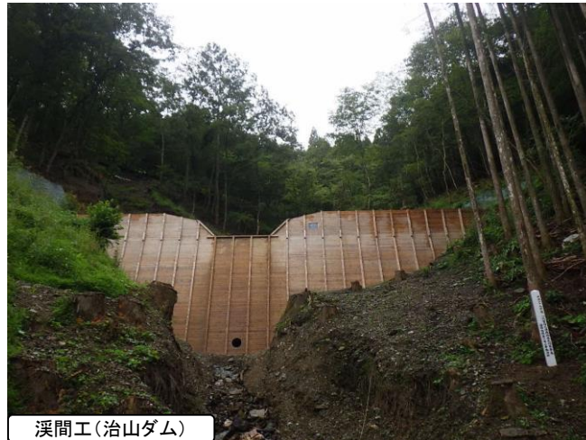
溪間工（治山ダム）
