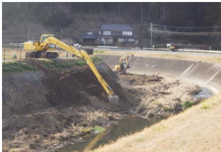
河道掘削イメージ
