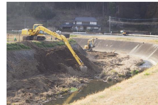
河道掘削イメージ
