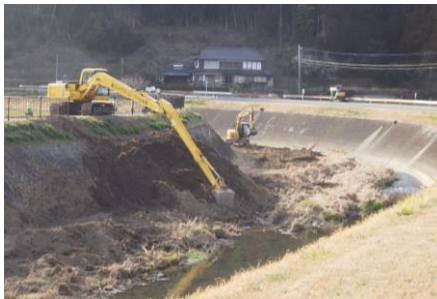
河道掘削イメージ
