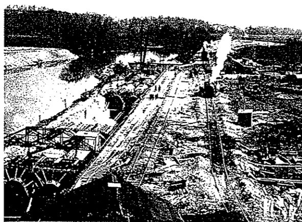
写真-6 分離型常用洪水吐きの施工状況
