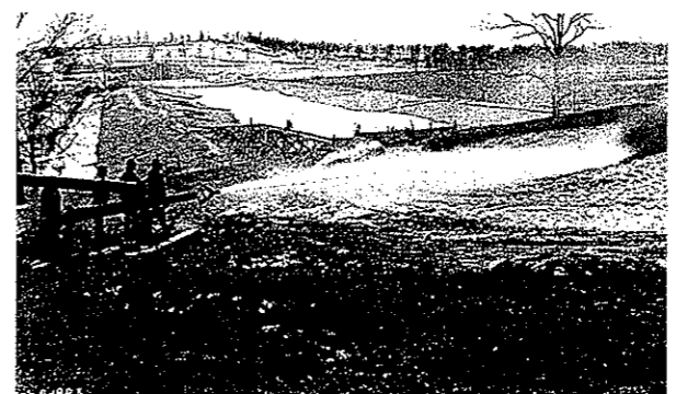
写真-7 コアゾーンの施工状況 (1/2)
