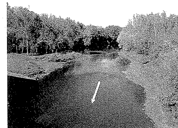
写真-6 ダム直上流の湛水池内河道 (Taylorsville ダム)
