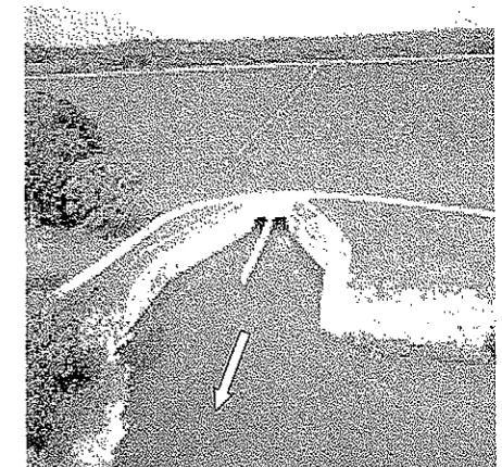
写真-8 洪水吐き (平常時) (Englewood ダム)
