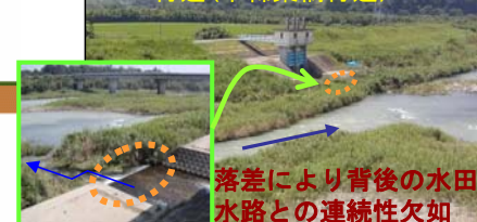
67km付近 (木綿葉橋付近)
