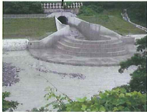
バイパストンネルの吐口の状況 (平成18年7月20日)
