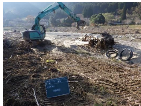
写真 5.13 ダム湛水区間における堆砂土砂の掘削や流木・ゴミの除去（市房ダム）
