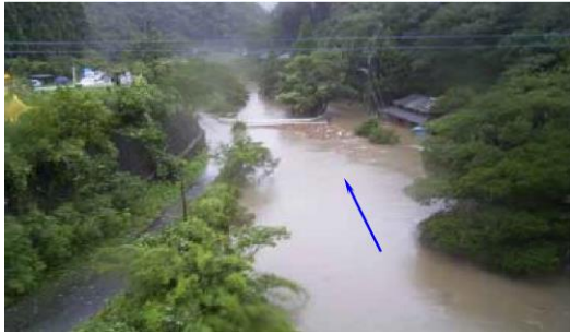
平成 16 年 8 月洪水による天月川・天月橋の浸水状況(芦北町)
