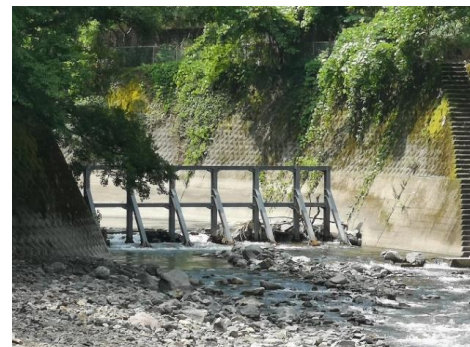
写真 5.2 流木止工施設の例 (油谷川下流)
