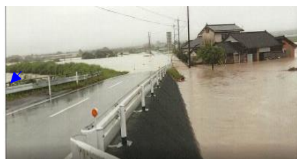
令和 2 年 7 月豪雨による柳橋川の氾濫状況
