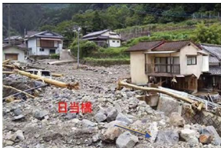
令和 2 年 7 月豪雨による川内川の河道埋塞状況(球磨村 神瀬地区)
