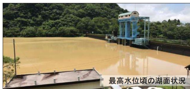
写真 2.3 市房ダムの湖面状況（令和2年7月豪雨）
