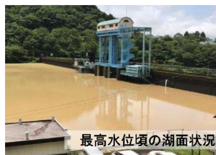
令和 2 年 7 月豪雨による市房ダムの貯水状況
