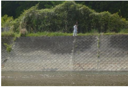
写真 5.11 河川点検・巡視の状況
