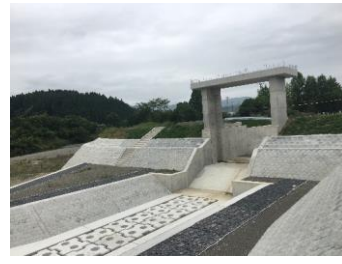
写真 1.92 御溝川整備状況 (2次放水路)
