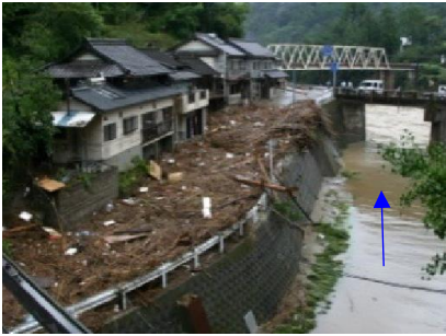
平成 17 年 9 月洪水による漆川内川の浸水後における状況(芦北町)
