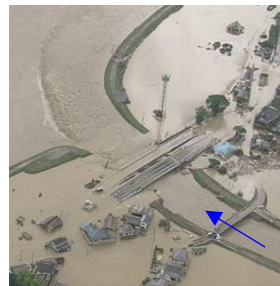
令和 2 年 7 月豪雨による小川の浸水状況(球磨村 渡地区)
