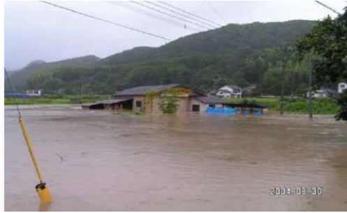
平成 16 年 8 月洪水による小川・小川橋の浸水状況(球磨村)
