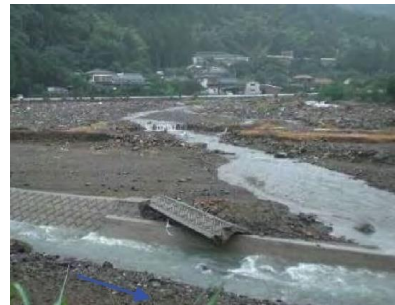
令和 2 年 7 月豪雨による吉尾川の河道埋塞・流路変更の状況(芦北町)
