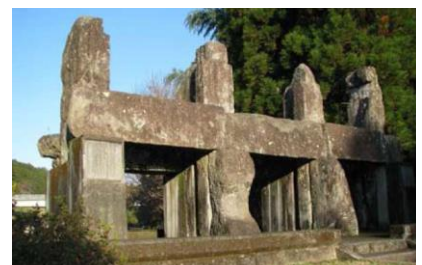
百太郎溝旧樋門 (世界かんがい施設遺産) (出典：八代河川国道事務所)
